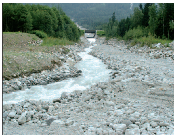
Fig. 8: Création d'une piste hors d'eau lors du curage de la confluence de la Creusaz et de l'Arve – Chamonix (Source: SM3A 2004)
